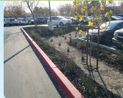
Proposed bioretention planter to capture and filter stormwater from new parking lot hardscape Propuesta de área de bioretencion para capturar y filtrar el agua de lluvia proveniente de el pavimento de el nuevo estacionamiento
