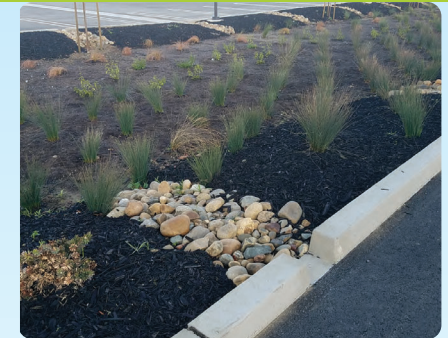
Proposed decorative and functional curb cuts at bioretention planter to allow stormwater entry Propuesta de cortes de cordones decorativos y funcionales en el área de bioretencion para permitir la entrada de agua
